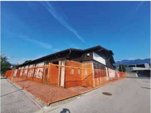
Priprava na rušenje Mercatorjevega objekta
