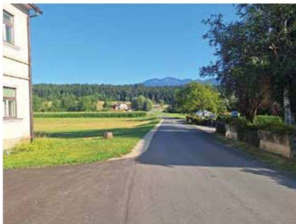
Zaključena je obnova mostu na lokalni cesti Govek–Kokarje.
