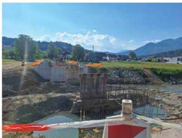
Nadaljuje se gradnja novega mostu na lokalni cesti Žlavor–Dobletina.
